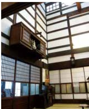
「盛岡町家」の特徴である「常居」。大きな神棚と、その上の吹き抜け部分がポイントです。
