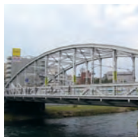
■開運橋 木製橋時代を含めて3代目の橋
