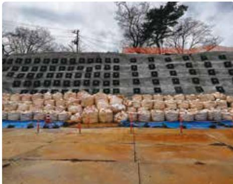
2023年3月現在の三ノ丸石垣。表面にモルタルを吹き付けてあるのは補修ではなく、石を積み直すまでの間、盛土が崩れるのを防ぐため。
